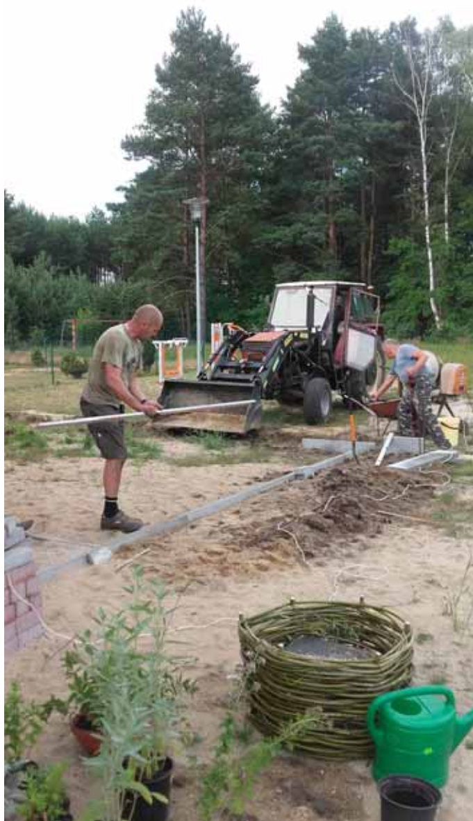
Na placu budowy panowie mają co robić.
