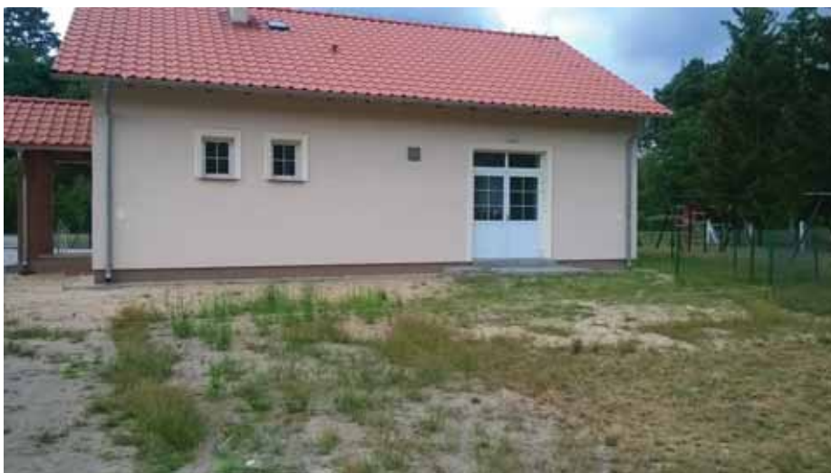
Tak wyglądał plac przed świetlicą przed rozpoczęciem prac.
